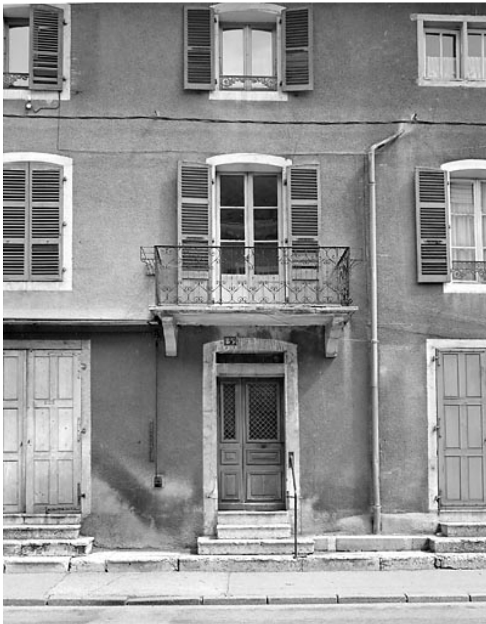
Façade antérieure : travée centrale.
