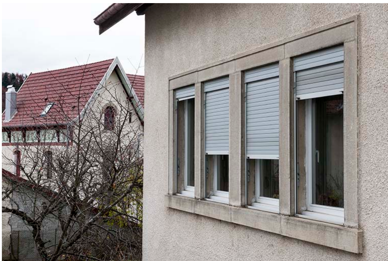
Façade latérale gauche : fenêtres multiples.
