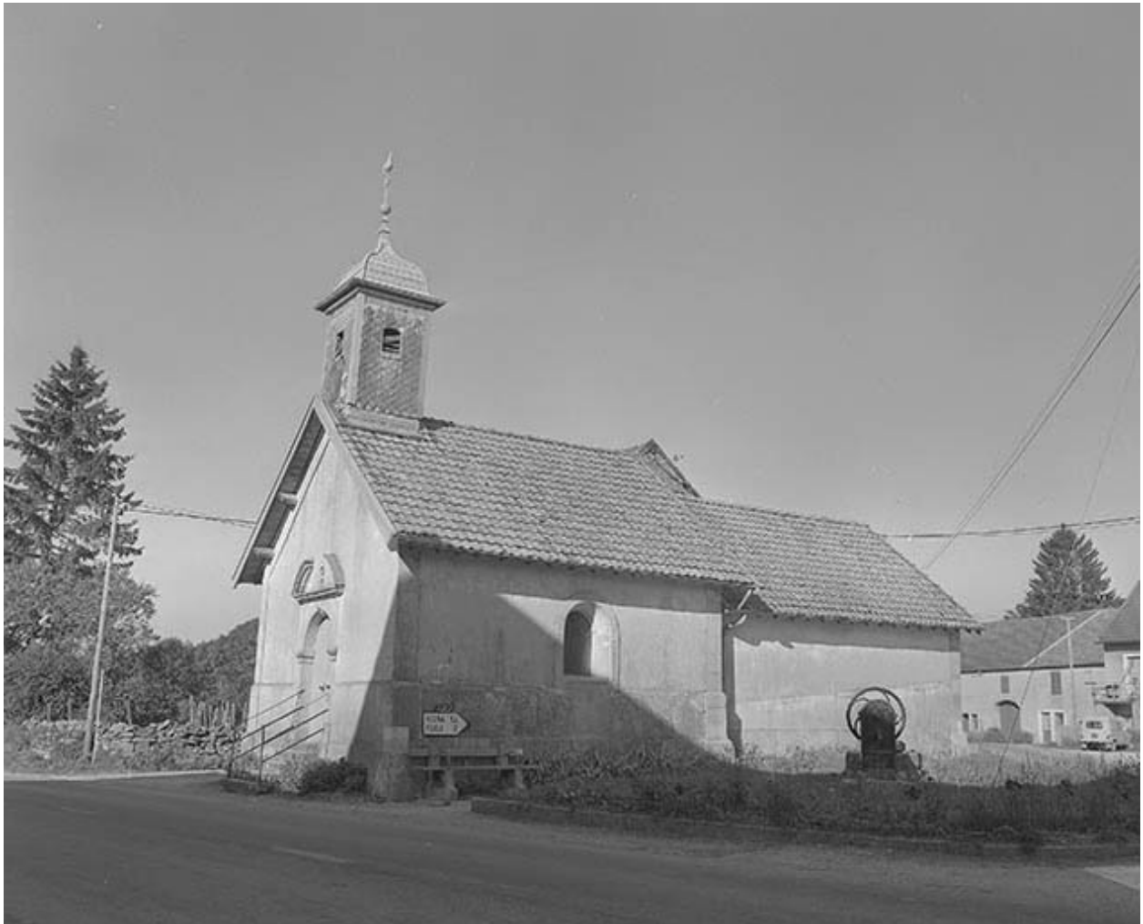
Extérieur : face latérale droite.
