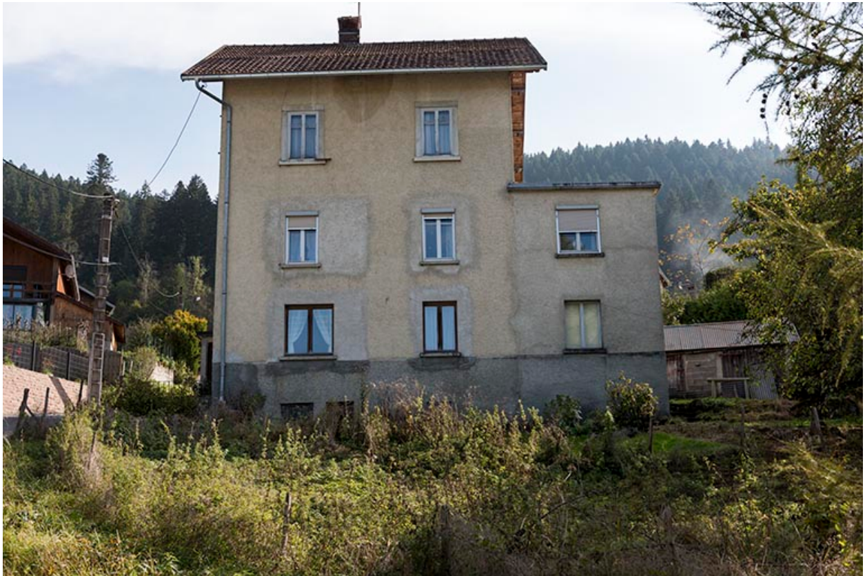
Façade latérale droite, vue en contre-plongée.
