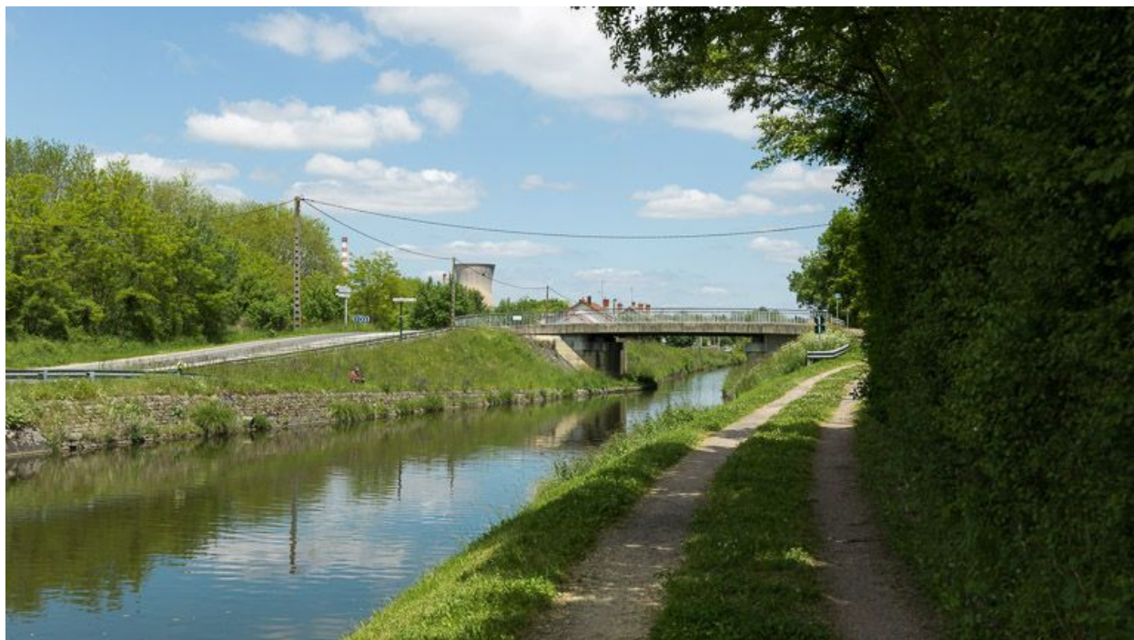
Vue d'ensemble du pont.
