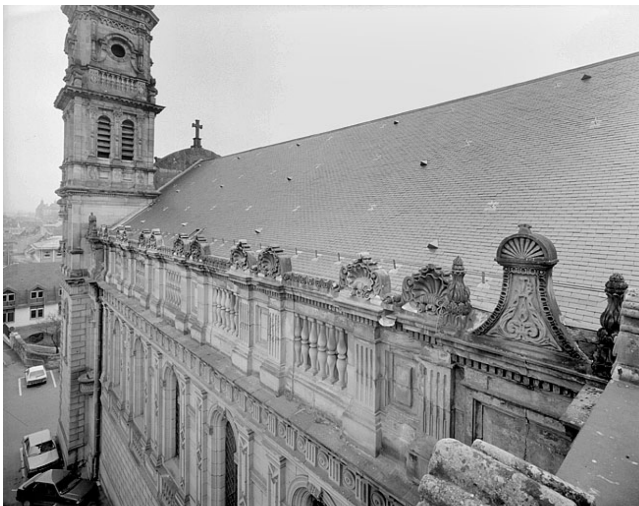
Couronnement de la nef, côté nord.
