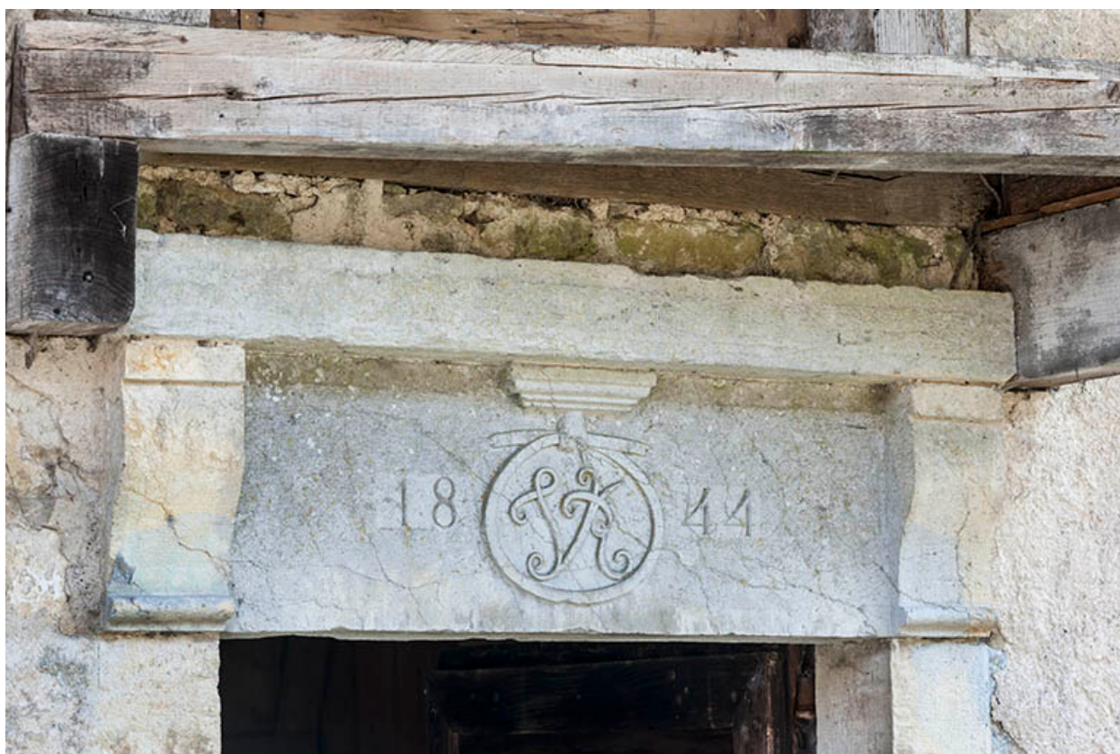
Mur-pignon ouest. Détail du linteau.
