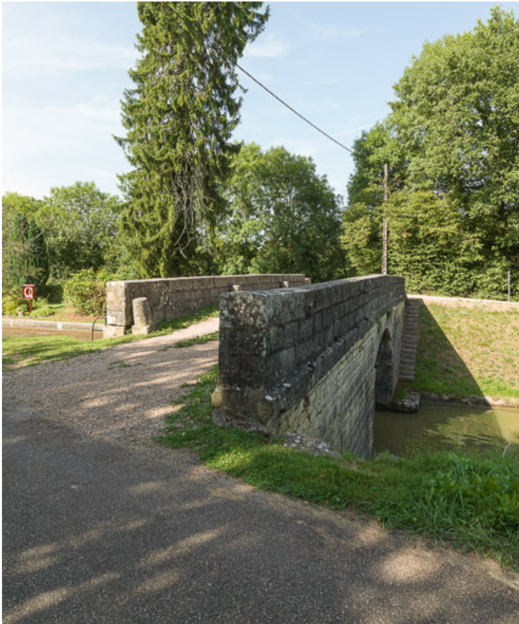
Vue du pont.
