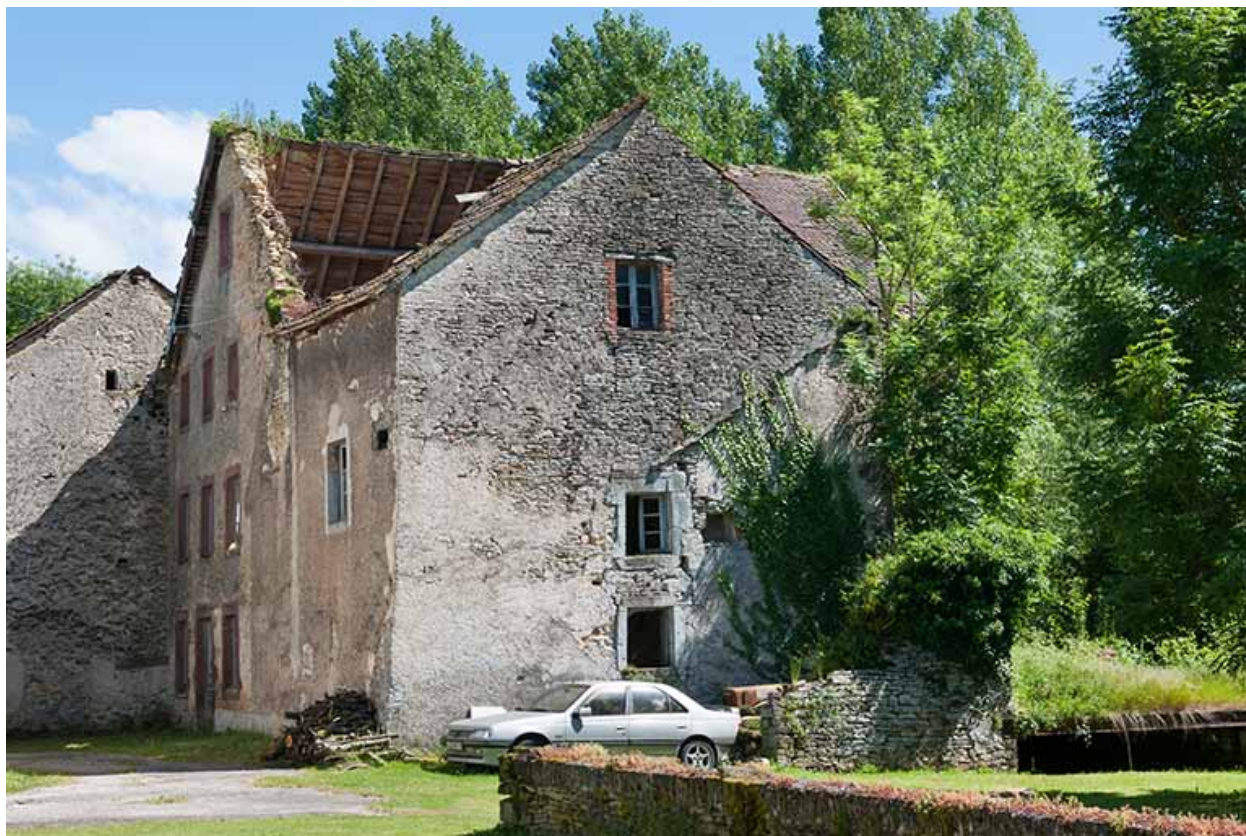
Le moulin depuis le nord-ouest.
