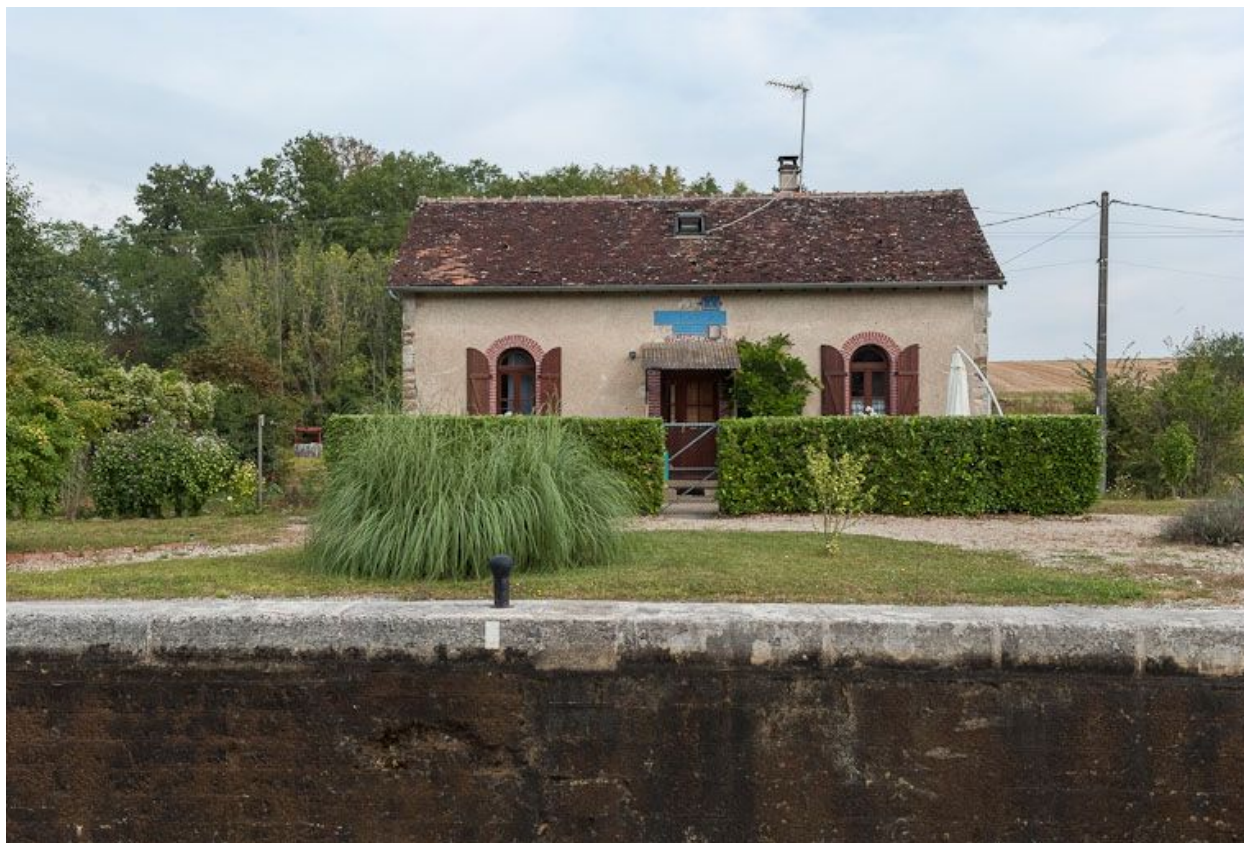
Maison éclusière vue de face.
