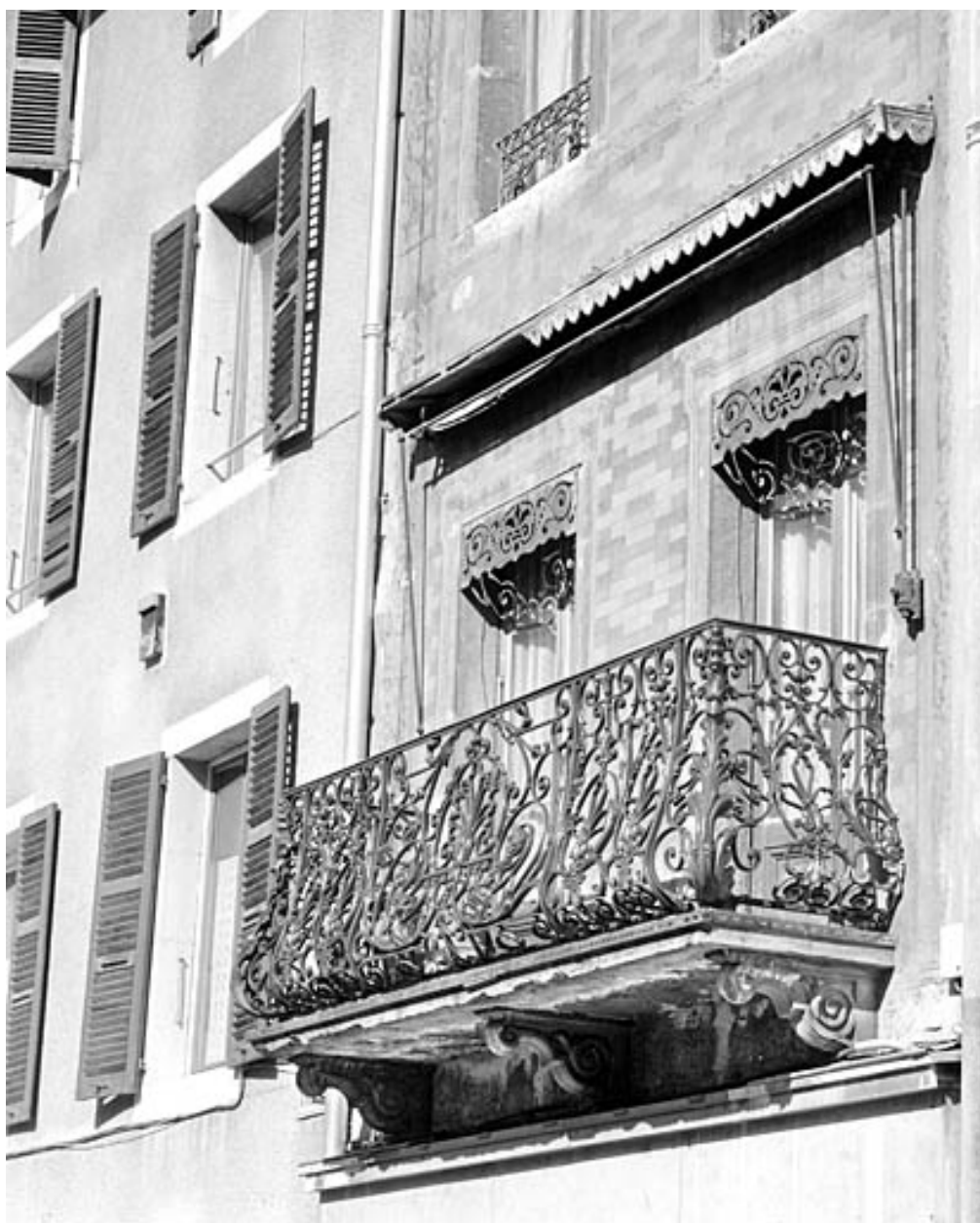
Balcon au premier étage.
