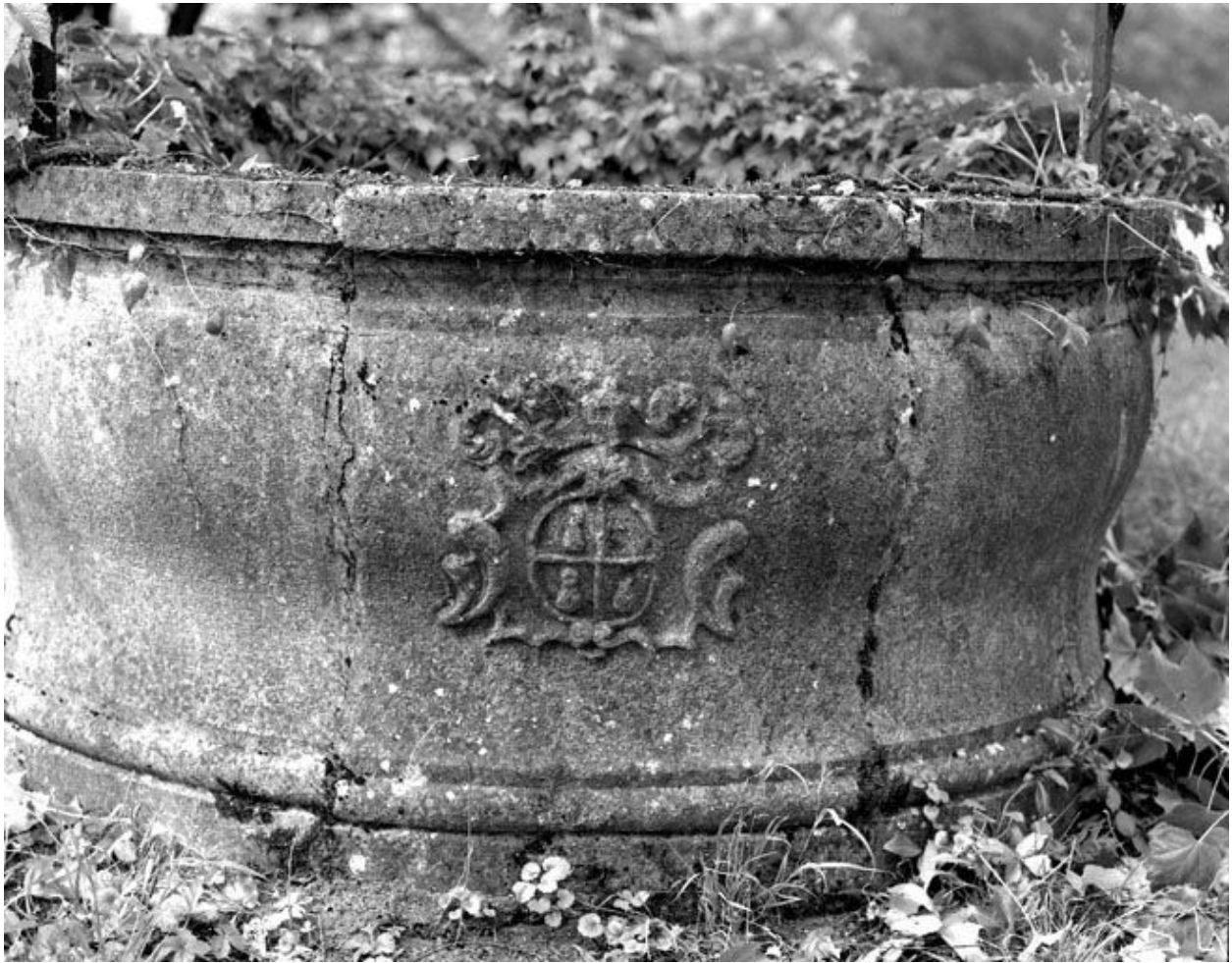
Blason sur la margelle du puits.
