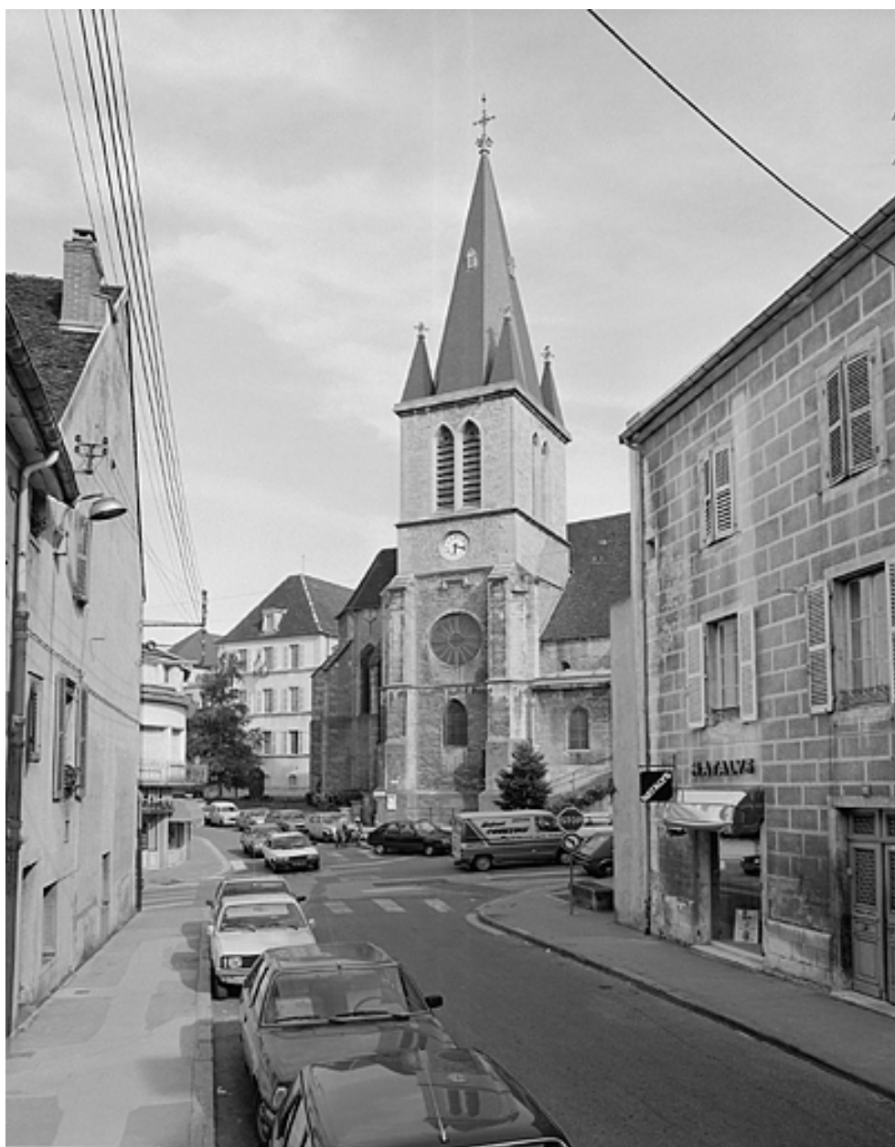
Eglise Saint-Désiré. Vue générale du clocher.
