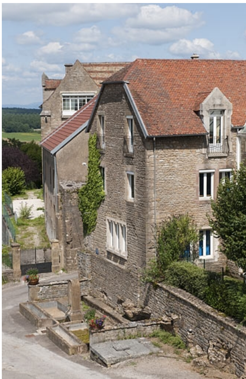
Bâtiment (A), vue rapprochée du côté rue.
