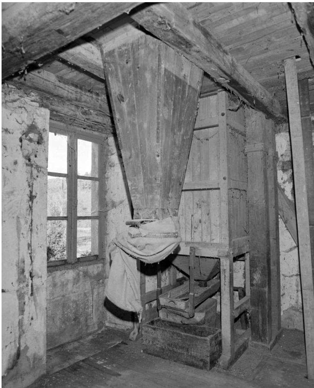
1er étage. Boisseau à farine et ensacheur.
