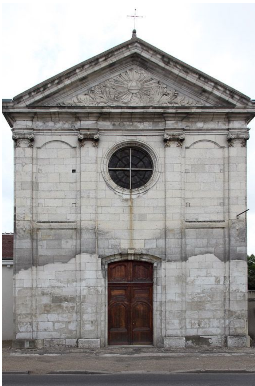
Façade de la chapelle.
