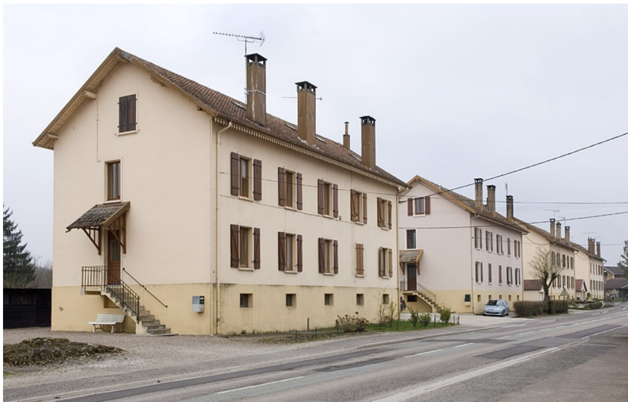
La cité ouvrière vue depuis la rue.
