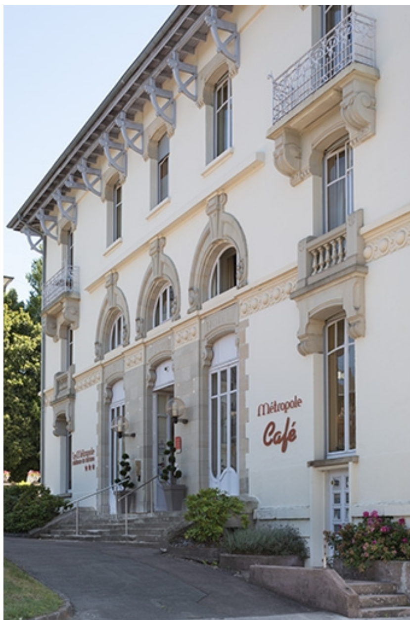
Façade nord, vue de trois quarts, détail.
