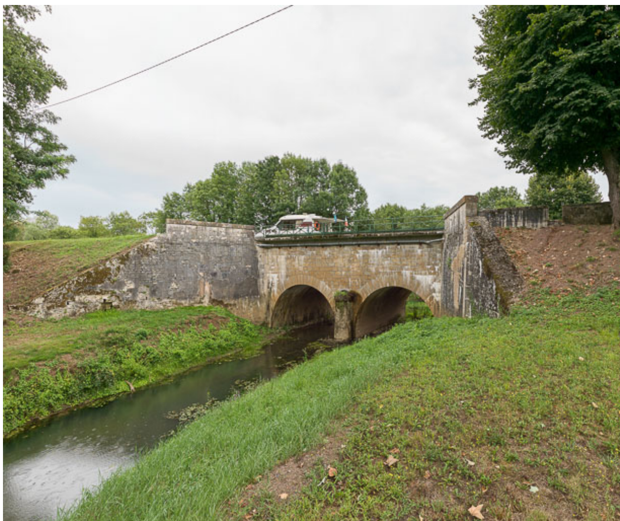
Vue d'ensemble, rive droite.
