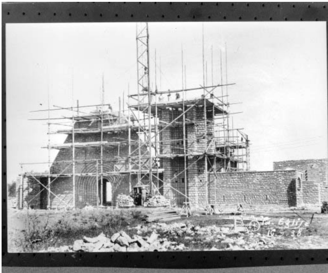
Travaux de construction de l'église, façade ouest.
