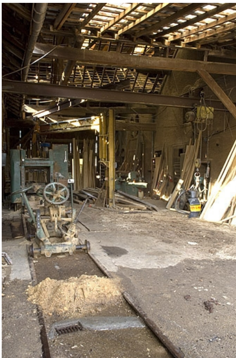
Atelier et charpente de la scierie.
