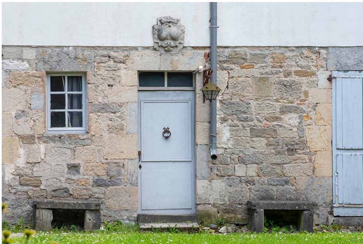
Détail du mur nord des communs.
