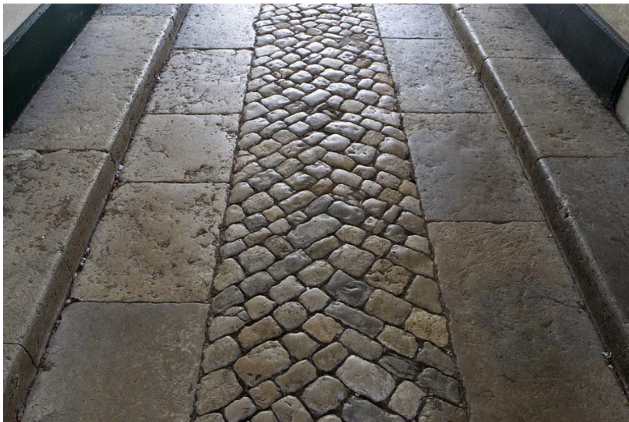
Passage couvert : sol de galets.
