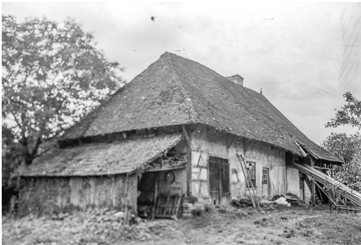
Façades antérieure et latérale gauche en 1975.
