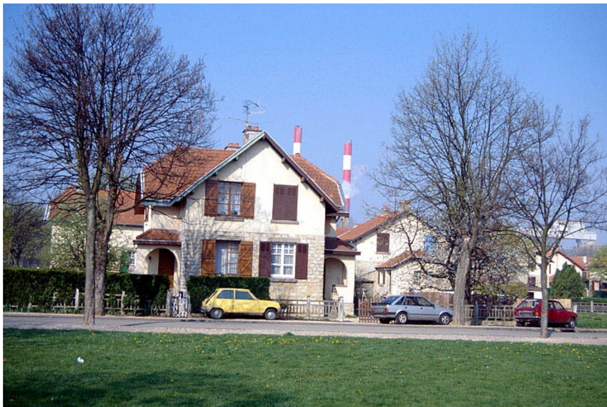
Maison d'ouvriers de type 10, 2, 4 avenue Albert 1er.
