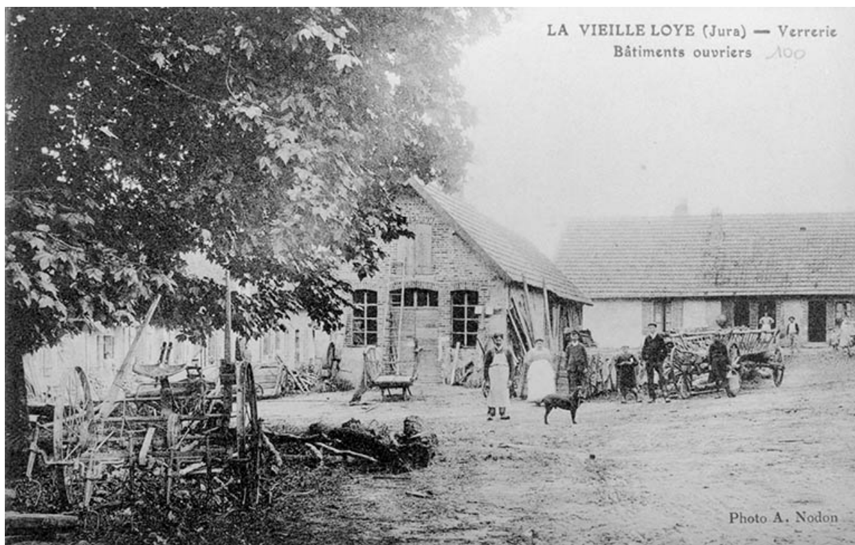
La Vieille-Loye (Jura) - Verrerie. Bâtiments ouvriers.
