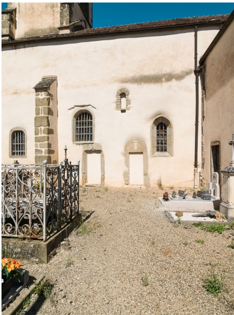
Elévation sud de la nef.
