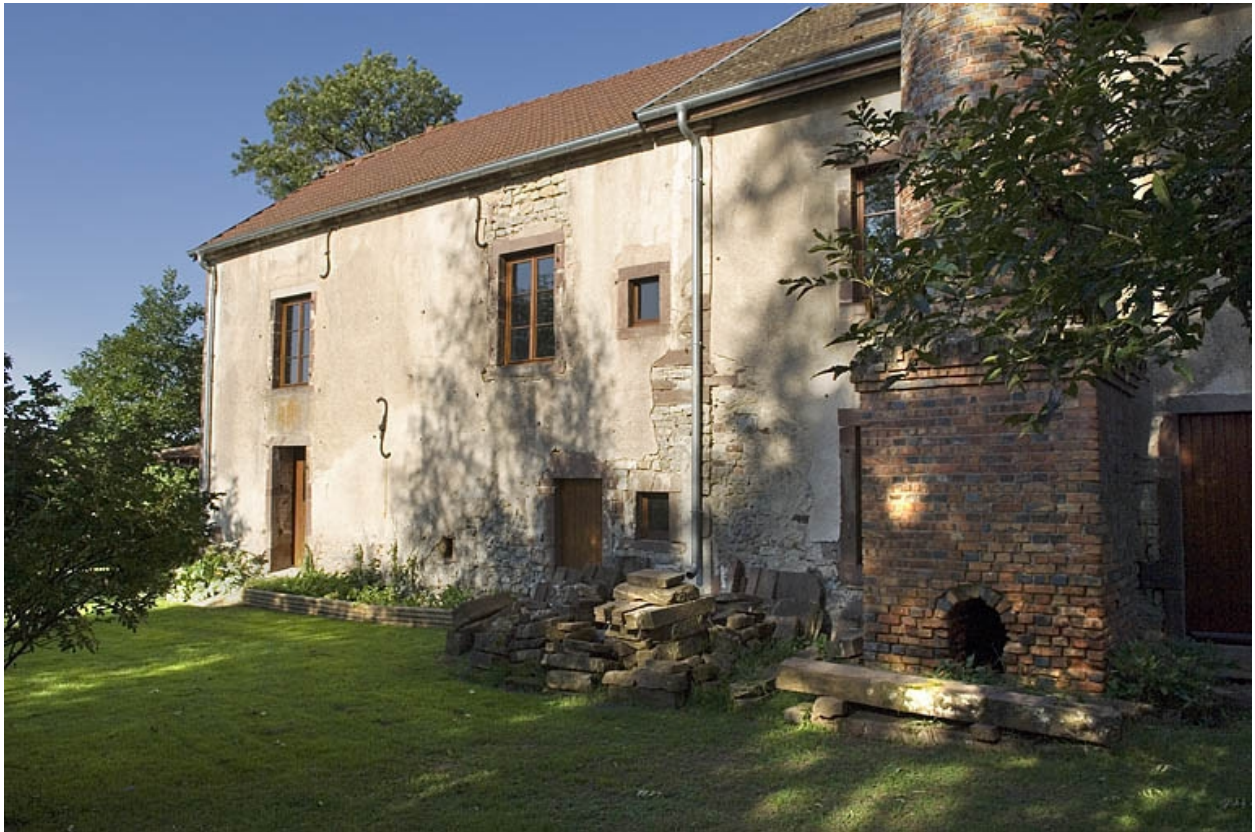
Partie sud (logement) de la façade postérieure.
