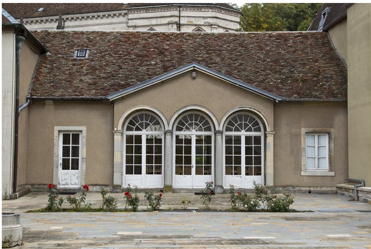
Orangerie : vue d'ensemble de la façade antérieure.
