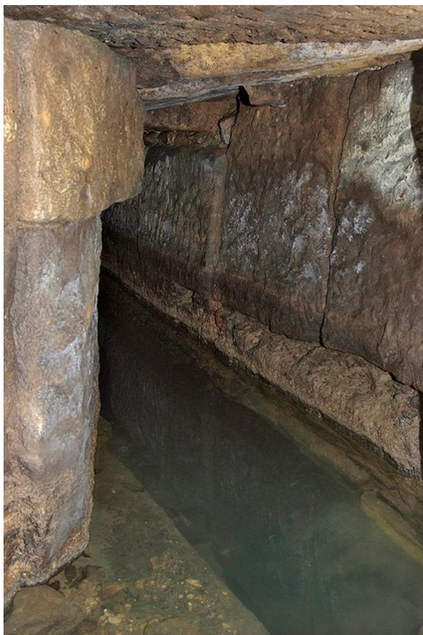
Première galerie : partie est.
