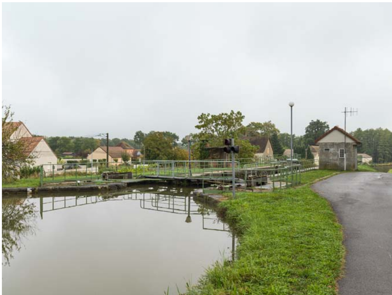
Vue d'ensemble du site d'écluse.
