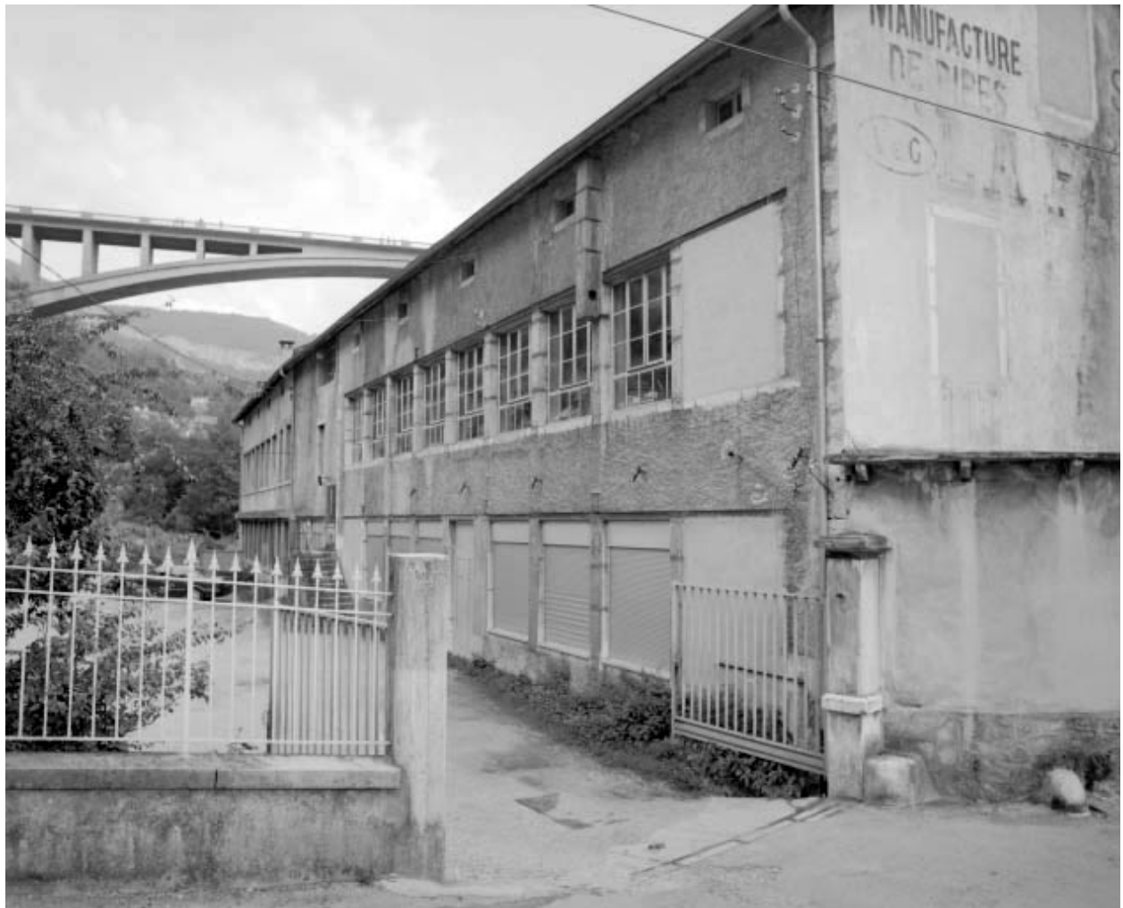
Façade sur cour des ateliers de fabrication.
