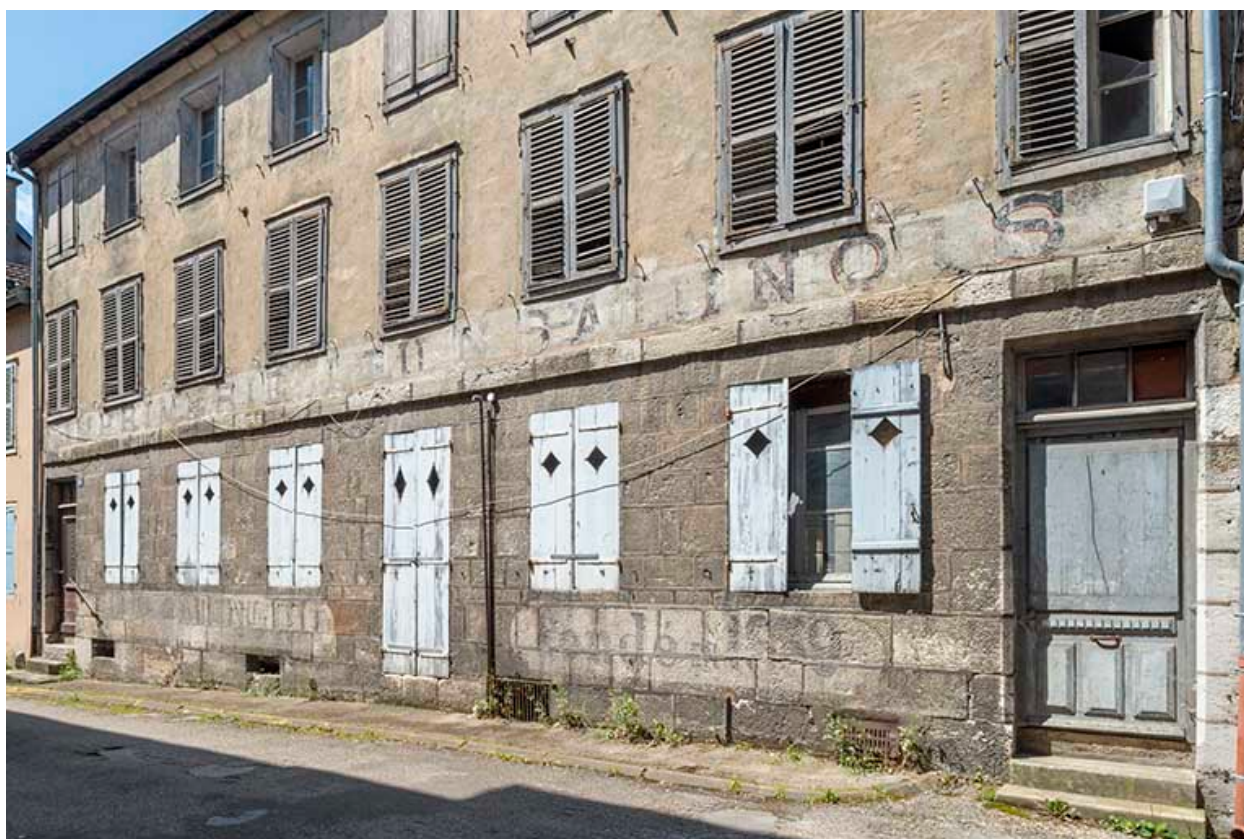
Façade postérieure (rue d'Orgemont). Partie inférieure.
