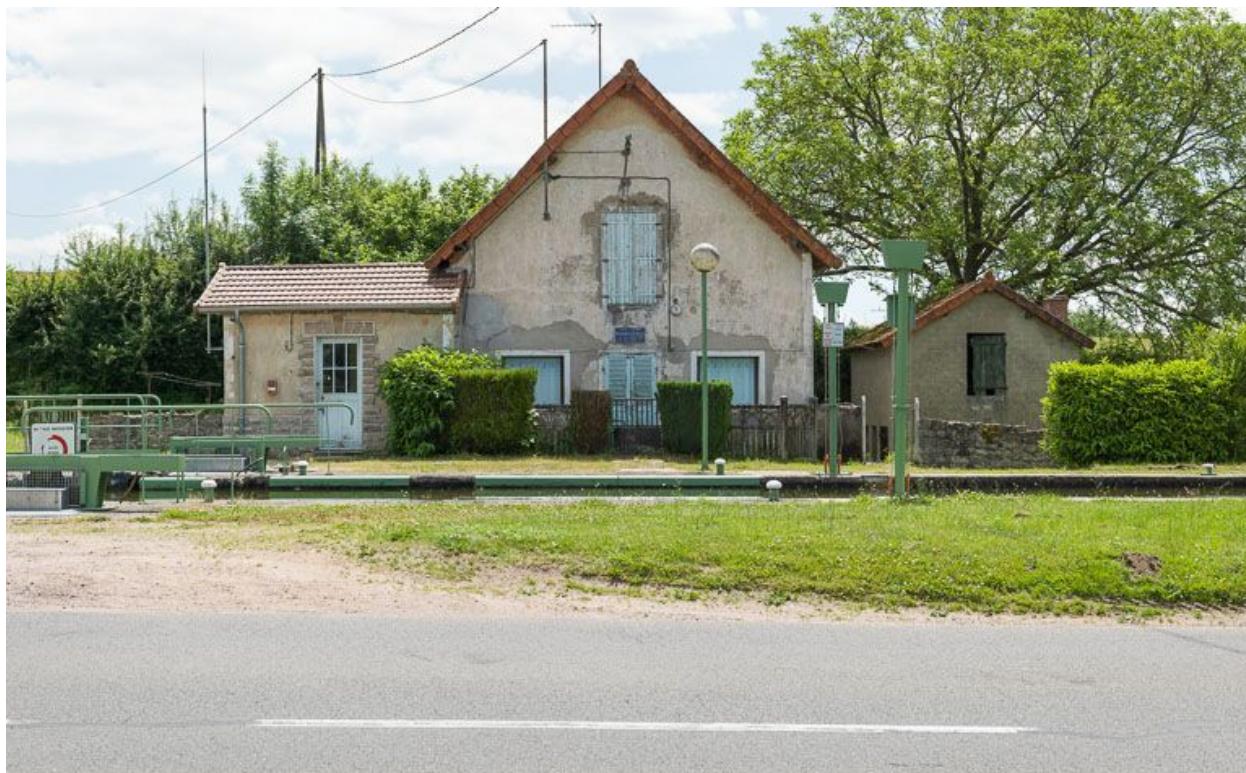
Vue de face de la maison éclusière.
