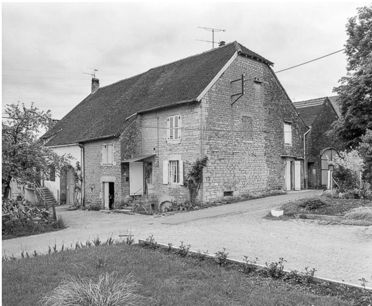
Façades antérieure et latérale droite.
