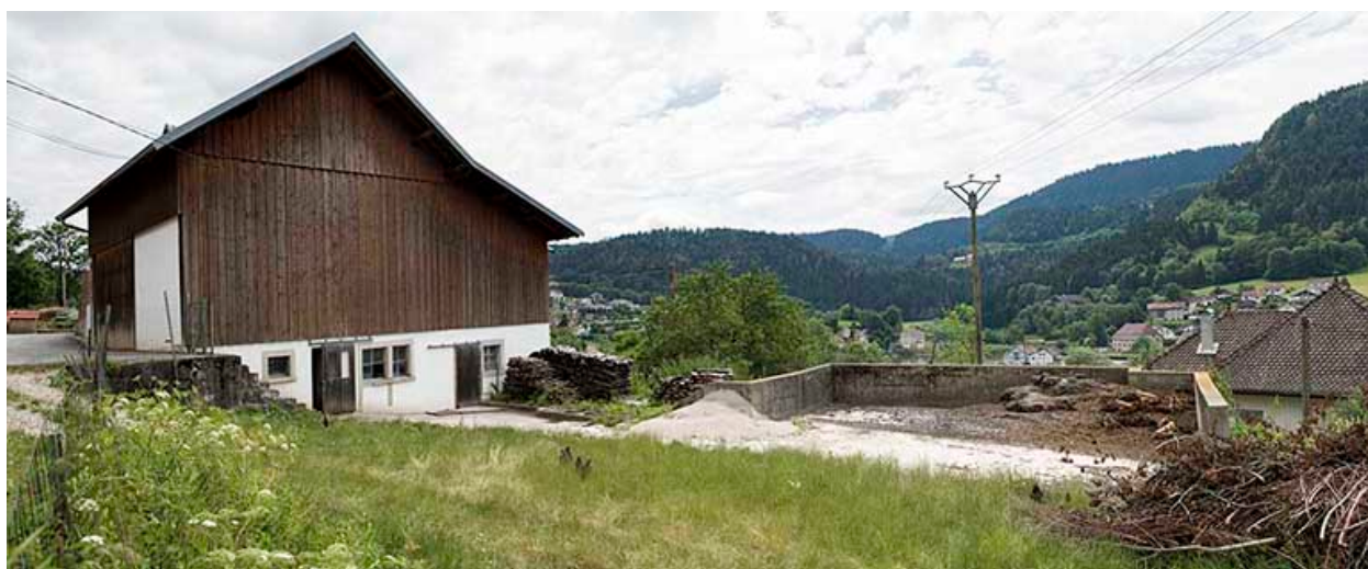
Façade postérieure de l'étable.
