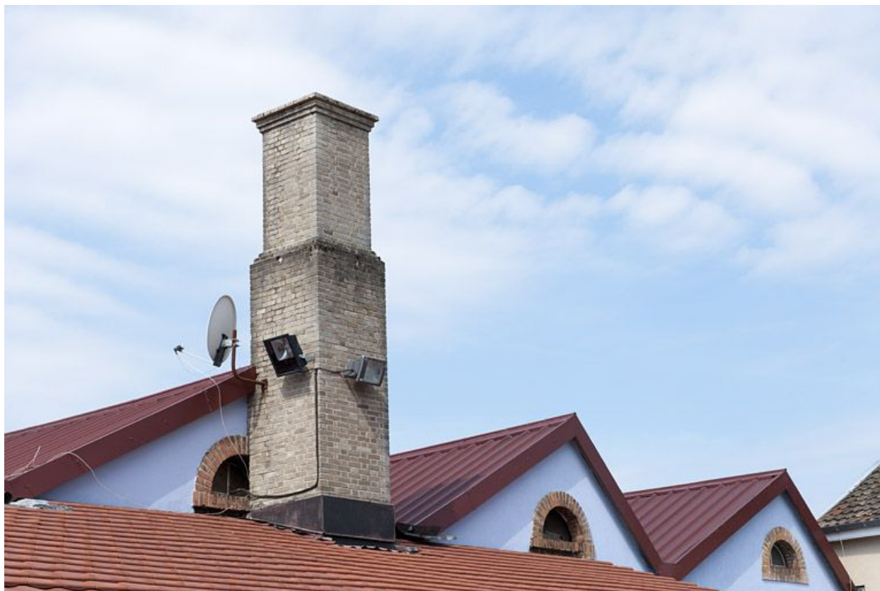
Détail de la cheminée de l'ancienne chaufferie.
