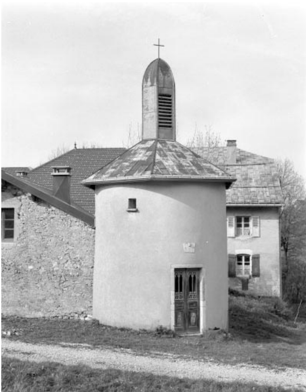
Tour transformée en oratoire.
