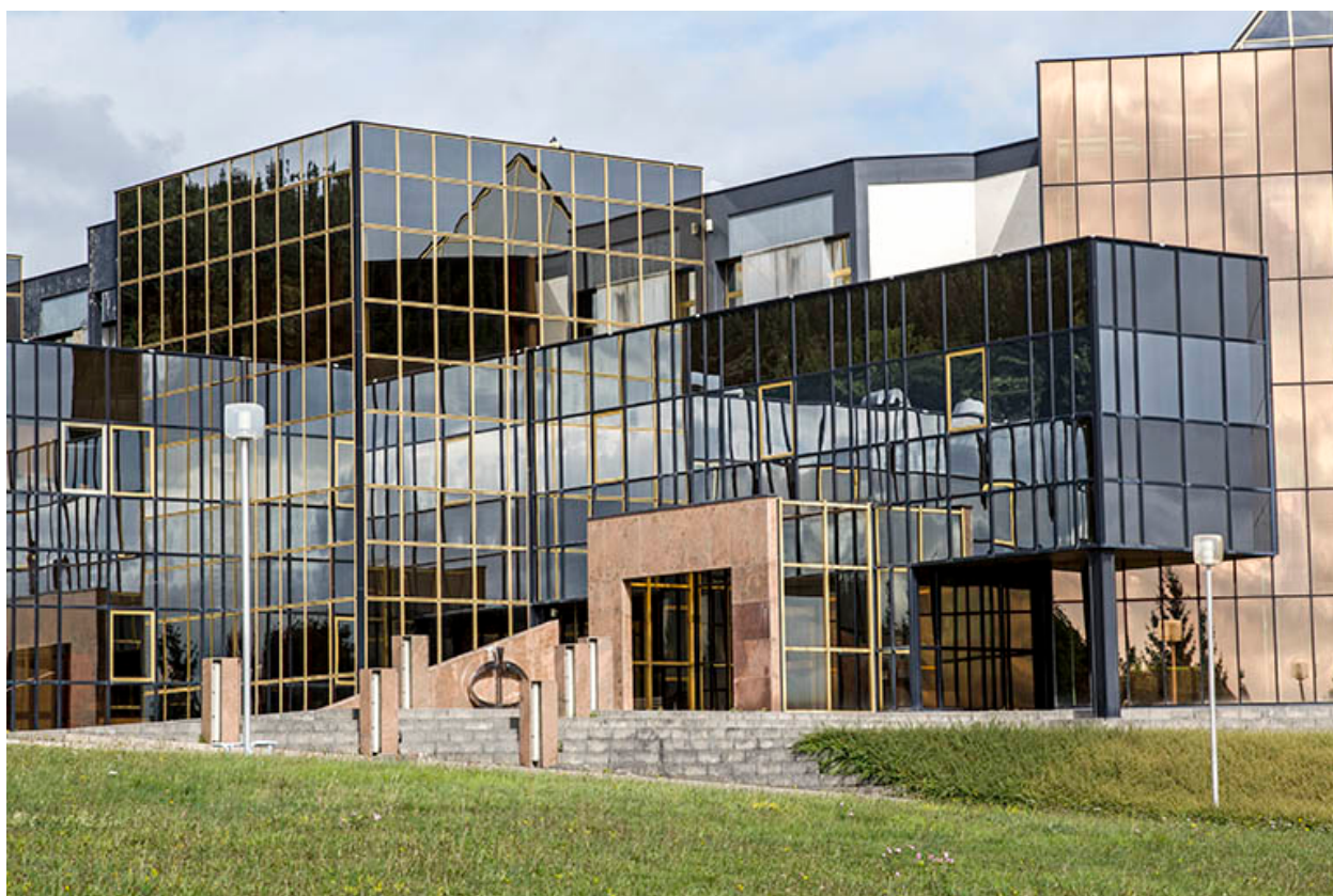
Entrée principale, depuis le sud-ouest.
