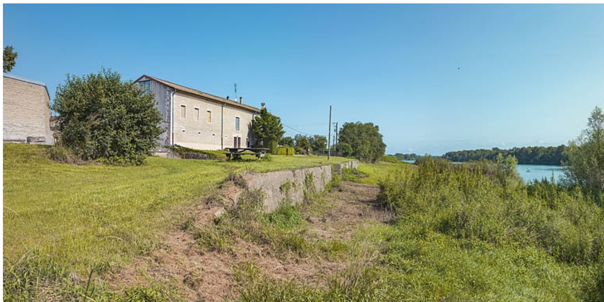
Mur de soutènement du port de Farges.
