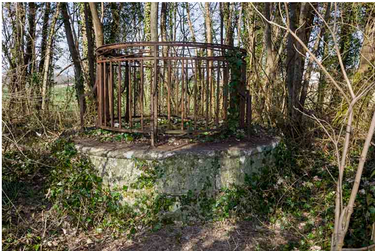
Puits d'aérage du tunnel.
