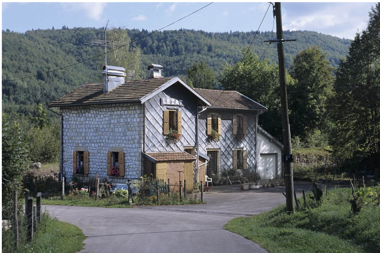
Façades antérieure et latérale gauche.
