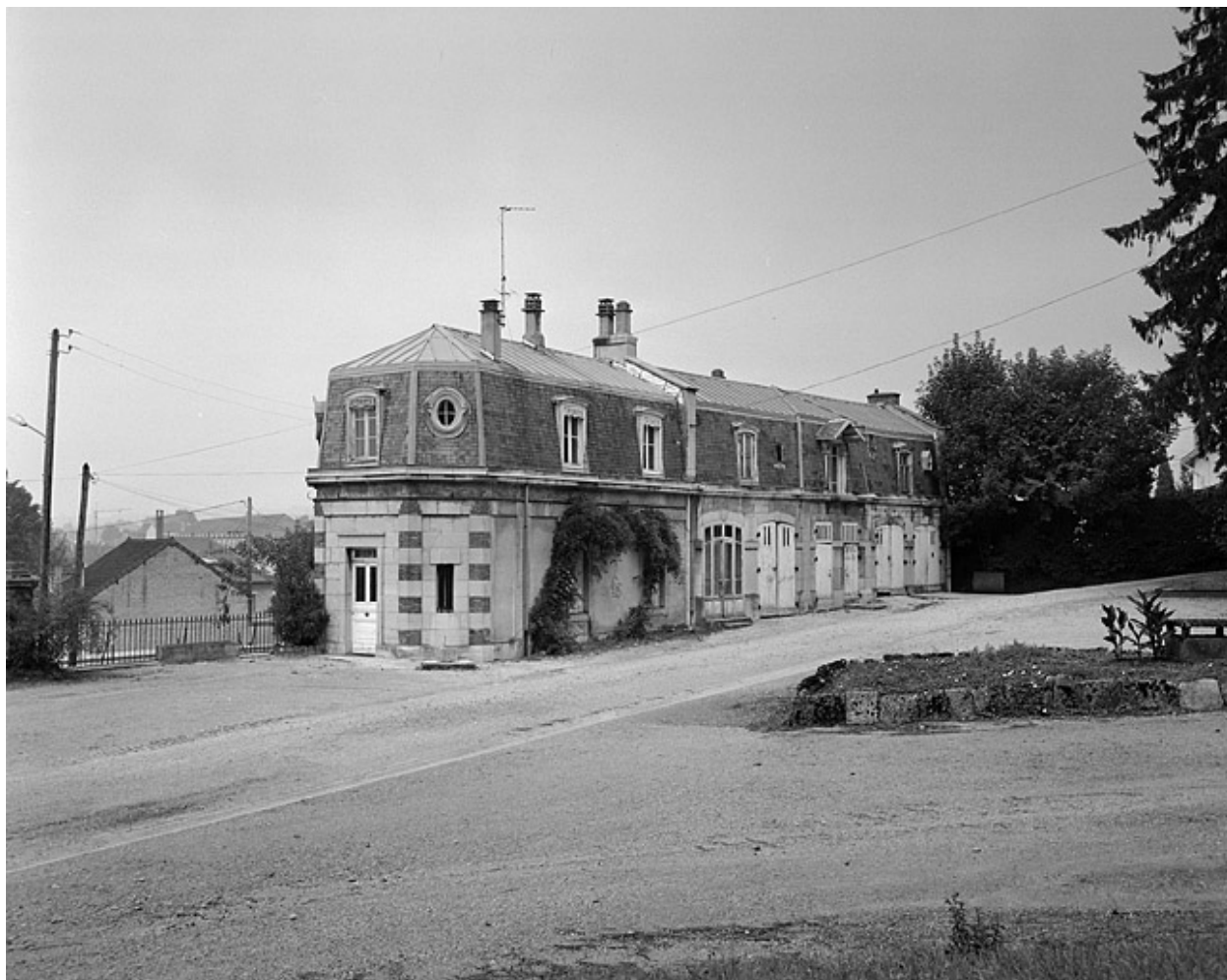
Bureau, logement et chai est.
