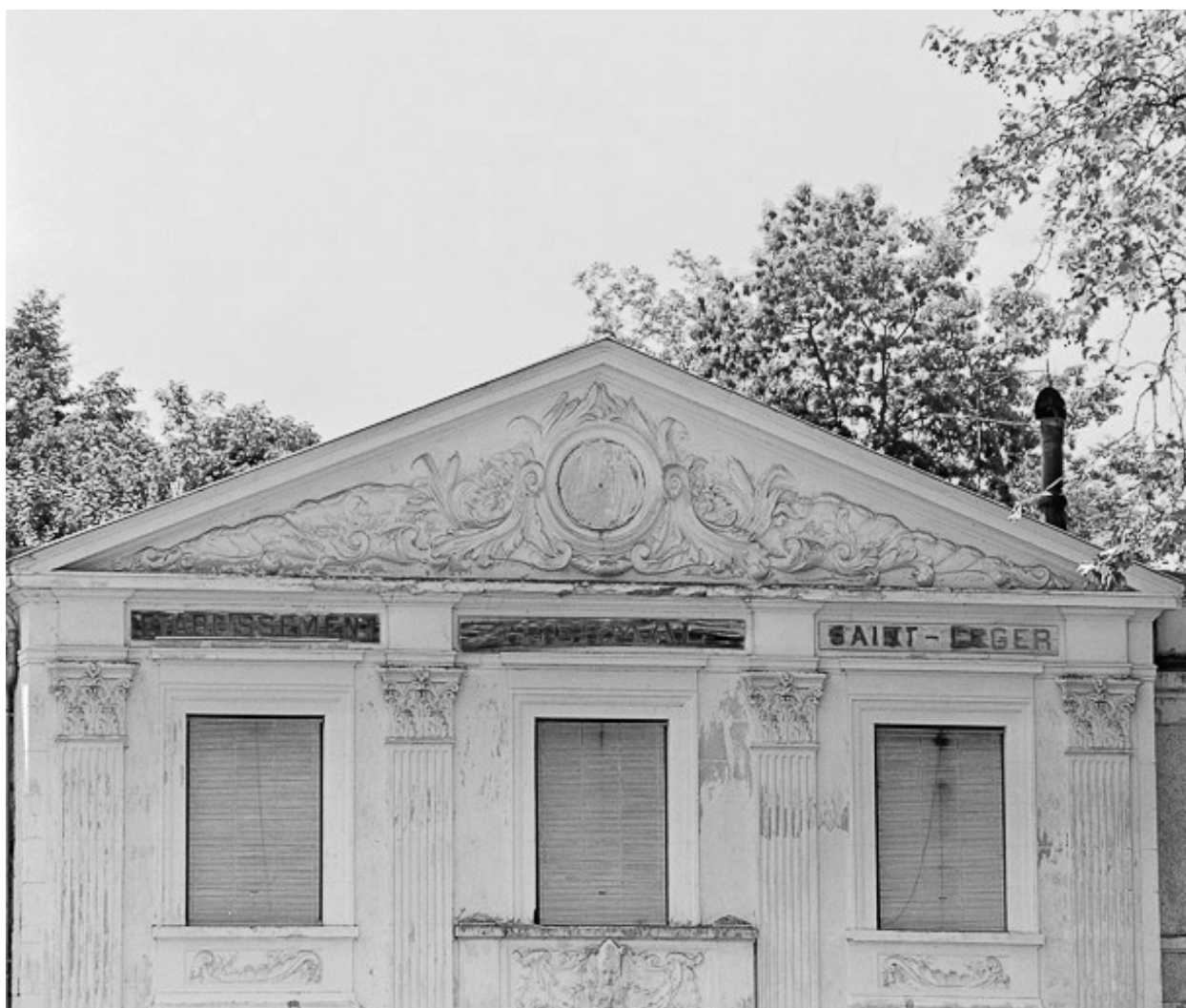
Façade antérieure, avant-corps, détail, fronton.
