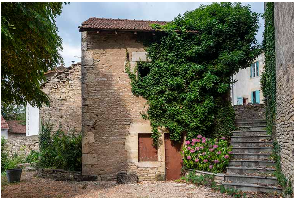
Remise du presbytère.
