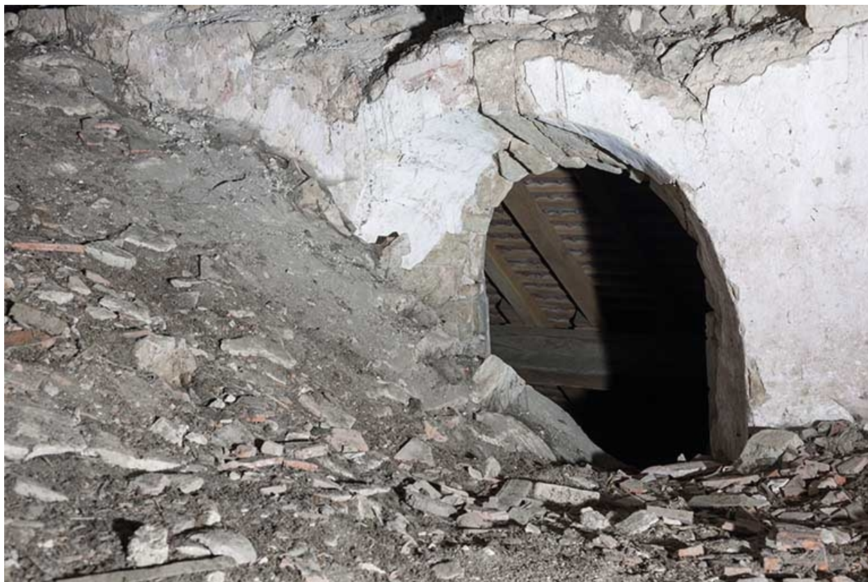
Ancienne baie au-dessus de la voûte.
