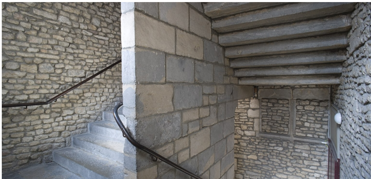
Détail de l'escalier principal en maçonnerie.
