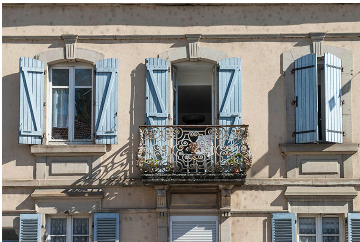
Etage carré, façade antérieure.
