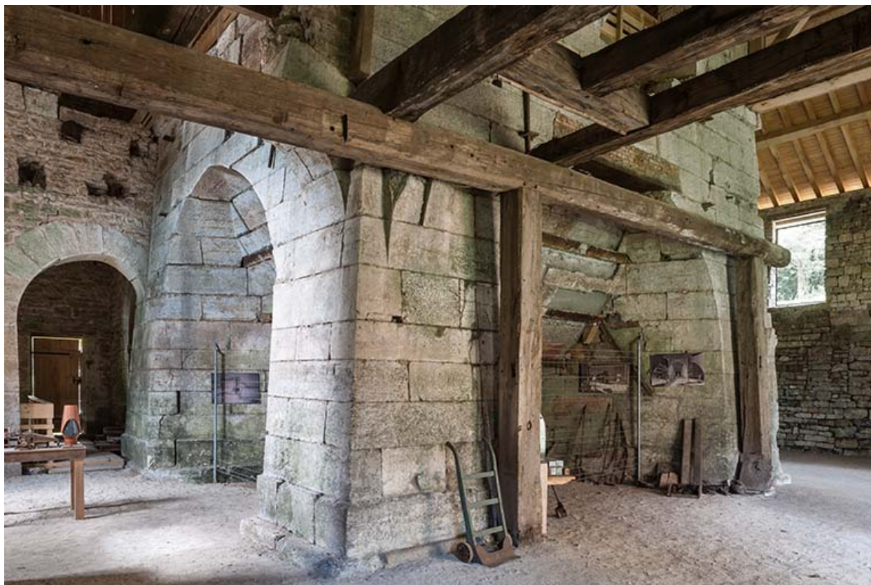
Haut fourneau. Vue rapprochée de trois quarts.
