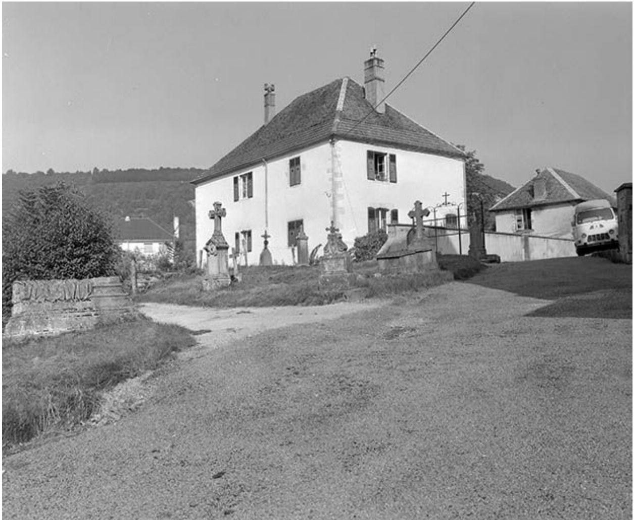
Façade postérieure et face latérale gauche.
